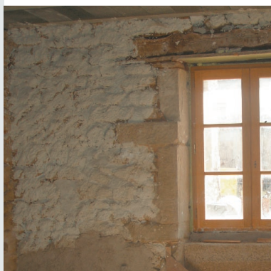
Application d'un gobetis (couche d'accroche) sur les supports sans accroche mécanique.
