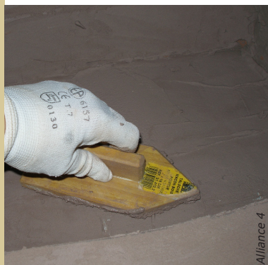
Chaque couche est talochée pour bien répartir l'enduit et applanir la surface.
