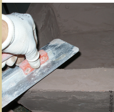
La deuxième couche est appliquée en appuyant fortement, lissée au platoir puis au galet ou avec un plastique.
